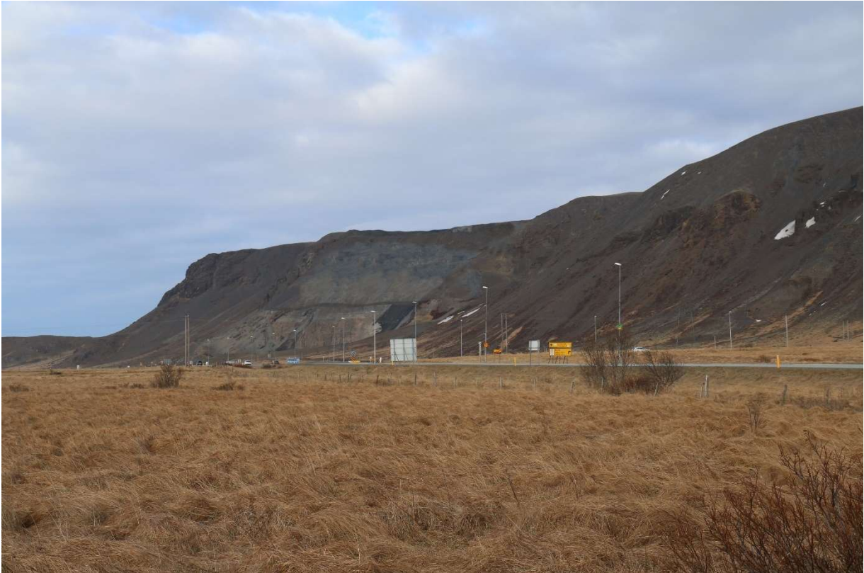
MYND 4.11 Þórustaðanáma séð frá Toyota-umboðinu þegar efnistaka er komin niður að þétta berggrunnum í botni fjallsins. Búið er að taka klettana í efri hluta fjallsins og er stallur rétt fyrir neðan miðjar hlíðar sem efni er ýtt fram af.
